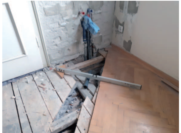
Oben: Errichtung von Wasseranschlüssen und Abfluss für die Küche
